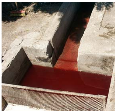
Para evitar la contaminación de la sangre y el agua, en la zona del desangre pueden utilizarse dos sistemas de drenaje independientes.
