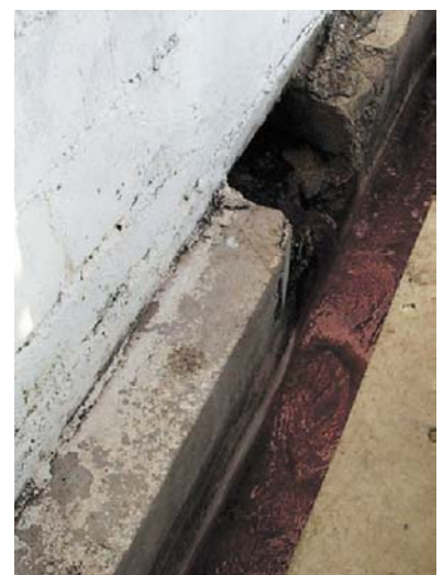
Desangrado de la sangre por canal de efluentes.
