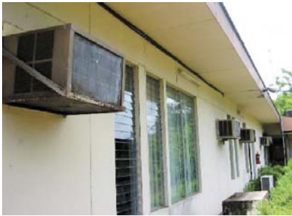
Área de oficinas de un matadero.
