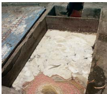
Trampas que impiden el paso de materiales sólidos en los efluentes.
