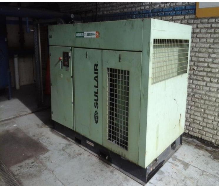
Líneas de Aire . Pasamos de 5 compresores a 3 compresores mejorando la EE de M3m colocando amplificadores zonales.
